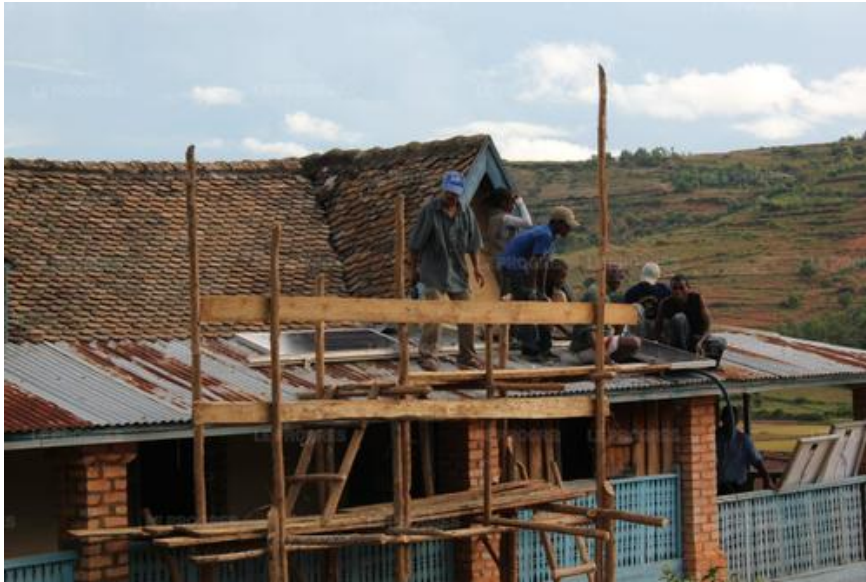
Installation de panneaux solaire par les élèves du lycée professionnel dans un village de Madagascar. Photo d'archives fournie par Electr'eau partage
