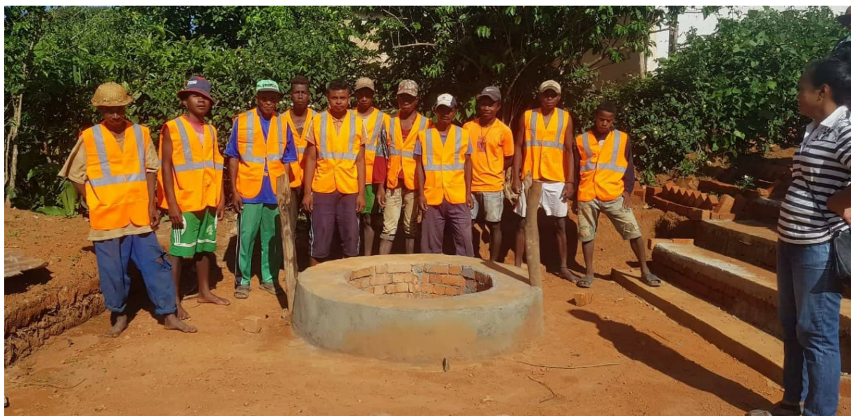
2018 : Puits creusé sur la commune d'Andranvoravito
